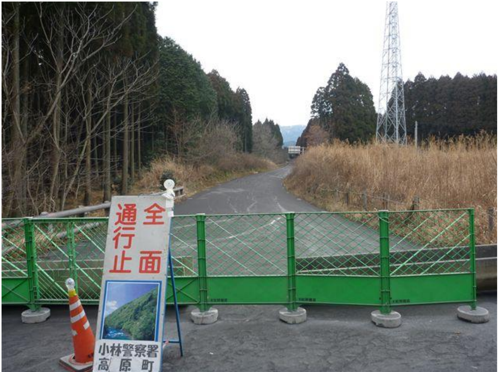
降灰の影響で通行止めになった道路
